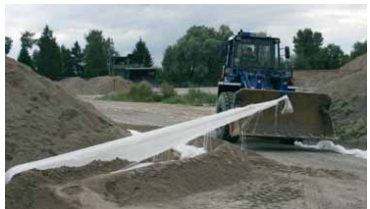
Beim Abbau wird der zuvor aufgeschlitzte Schlauch mit der Schaufel aus dem Damm herausgezogen.
