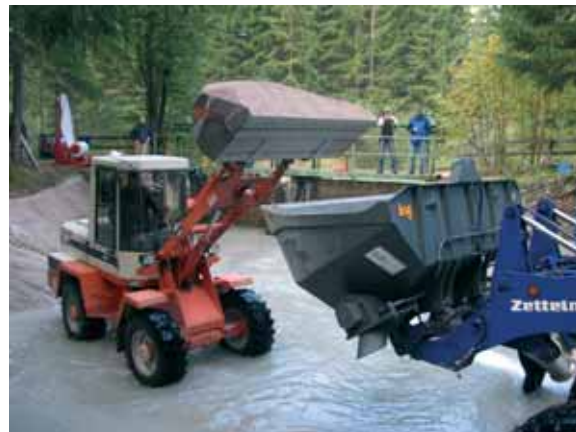
Mit einem weiteren Radlader lässt sich der Zeitaufwand für den Bau eines Sandschlauchdamms erheblich verkürzen.
