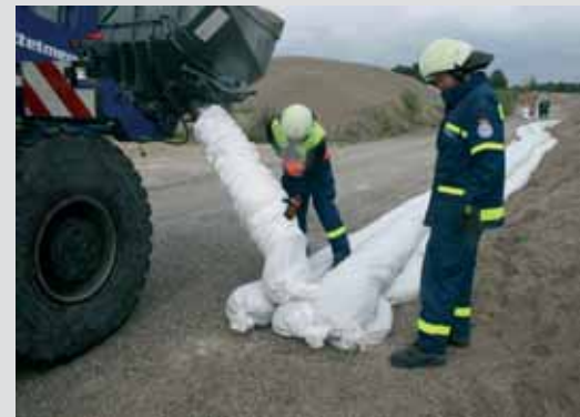
Die Verlegung des Sandschlauchdamms ist mit nur sechs Helfern innerhalb kürzester Zeit möglich.
