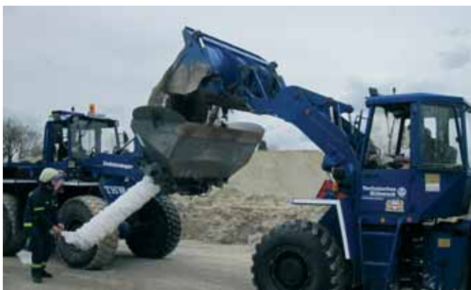
Im Verlegebetrieb kann die Sandschlauchschaufel durch einen zweiten Radlader schnell befüllt werden.
