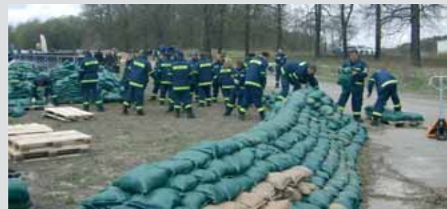
Der Bau eines Schutzdamms aus Sandsäcken erfordert einen hohen Zeitaufwand und viel Personal.
