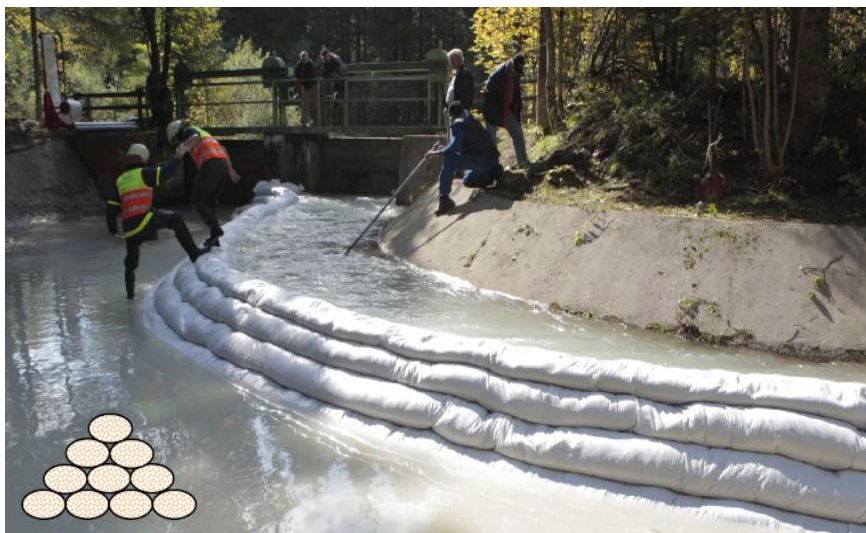
Damm, 4-lagig, belastet mit strömendem Wasser auf der Kurveninnenseite
